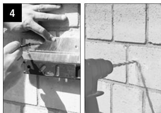
4 Anzeichnen, ausrichten und bohren.
