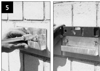
5 Befestigungshalter ausrichten, festschrauben. Schrauben und Dübel je nach Untergrund und Anlagengewicht verwenden (bauseits!)
