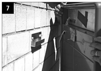
7 Kabel einziehen und Anlage einhängen.
