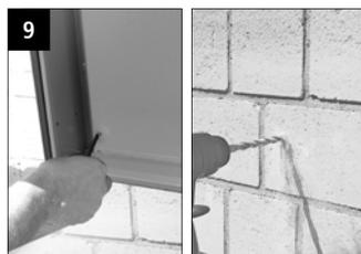
9 Bohrungen für die unteren Abstandhalter anzeichnen. Anlage entfernen und bohren.
