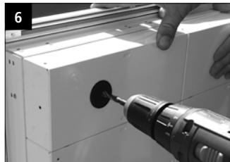
6 Kabelabdeckkappe entsprechend des Kabeldurchmessers aufbohren. Nicht entfernen - Kabelschutz!
